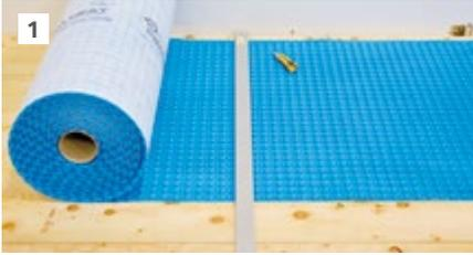
1 Taillez la membrane et ajustez à sec de façon à couvrir tout le plancher. Alignez les crampons d'une feuille à l'autre.
