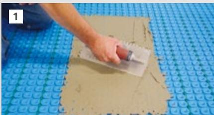
Avec le ciment-colle approprié, remplissez la membrane avec le côté plat de la truelle.
