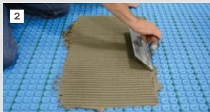
Ajoutez du ciment-colle et créez des stries avec le côté dentelé d'une truelle appropriée.
