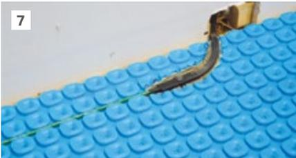
7 Pour débuter l'installation du câble chauffant, coupez la membrane pour y insérer le joint mécanique et la partie de la liaison froide nécessaire.
