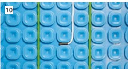
10 Installez la sonde de plancher entre 2 passes de câble. Suivez les instructions du fabricant de câbles chauffants.
