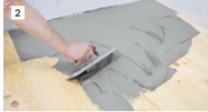
2 Étendez le ciment-colle approprié sur le sous-plancher avec le côté plat de la truelle pour le faire pénétrer dans le support.
